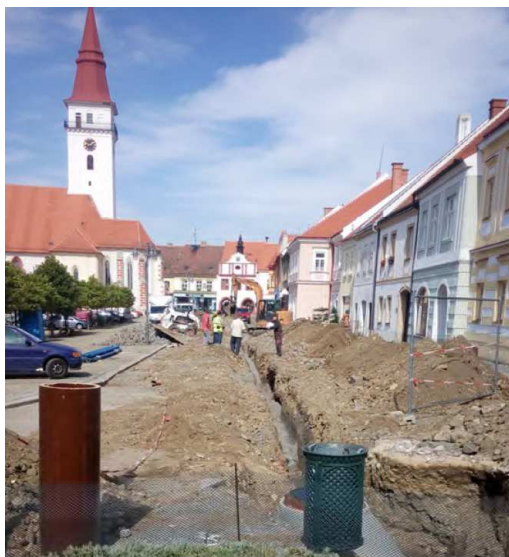
Rekonstrukce kanalizace na náměstí v Jemnici v roce 2016
