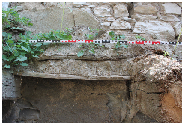
P.05_12. Východní stěna, detail pozůstatku stropu (P.05_D), pohled od západu.
