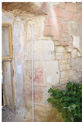
1.04_04. Jižní stěna, okenní otvor O_{10} 1.04_01, západní špaleta s náleзовou situací 1.04_B, pohled od severovýchodu.
