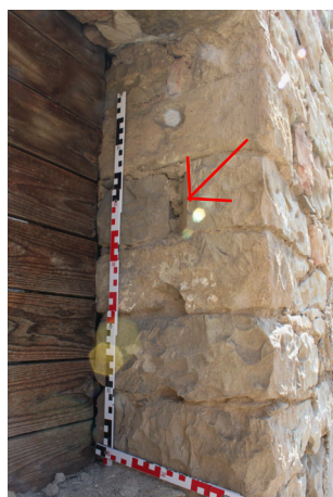
E.01_12. Jižní průčelí jižního traktu, okenní otvor O 1 P.01_01, detail kapes po mříži ve východním ostění, pohled od jihozápadu.
