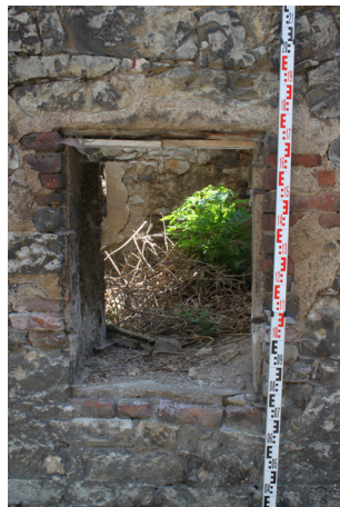
P.05_04. Západní stěna, rubová strana okenního otvoru O 6 P.05_01, pohled od západu.
