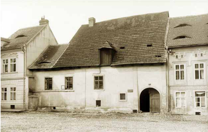
E.01_01. Jižní průčelí jižního traktu, stav kolem roku 1900 (Muzeum Žatec inv. č. Fn-51), pohled od jihu.
