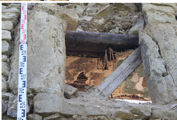
1.05_15. Severní stěna, okenní otvor O 13 1.05_01, pohled od jihu.
