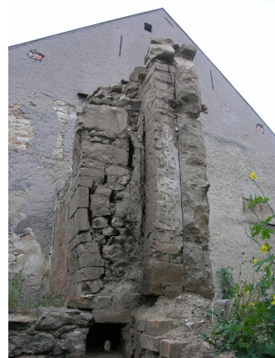
1.06_05. Jižní stěna, situace 1.06_C , pohled od severozápadu.
