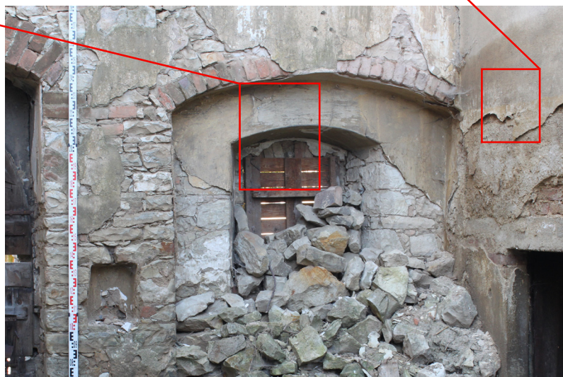
P.01_04. Jižní stěna, okno O 1 P.01_01, pohled od severu.
