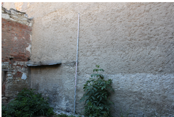
P.01_48. Východní stěna, severní část, pohled od jihozápadu.
