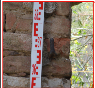
1.05_07. Západní stěna, vstupní otvor D 8 1.05_01, detail střežeje (1.05_C), pohled z exteriéru od západu.
