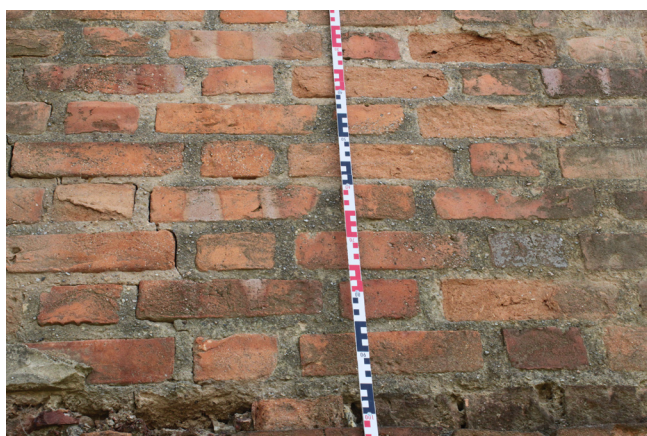
1.07_03. Jižní stěna, východní část, detail polokřížové či tzv. gotické vazby, pohled od severu.
