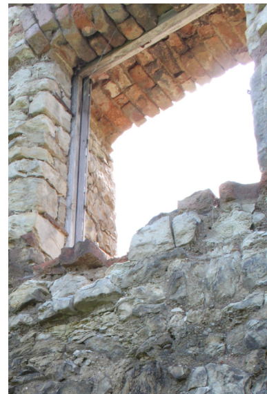
E.04_07. Severní průčelí severního traktu, okenní otvor v patře střední osy O 14 1.06_01, pohled od severu.
