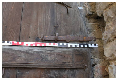
P.01_11. Vrata V 1 P.01_01, detail zástrče jistící horní část západní poloviny, pohled od severu.
