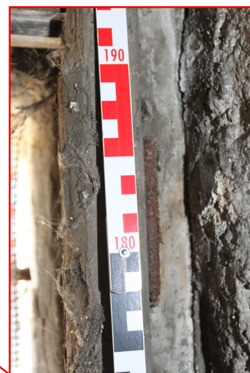
P.02_04. Jižní stěna, okno O 3 P.02_01, detail závěsu, pohled od severovýchodu.
