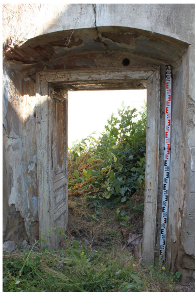
1.03_21. Vstupní otvor D 7 1.03_01, pohled od východu z místnosti 1.02.
