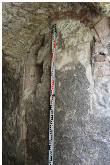
P.04_05. Severní stěna, portál P 3 P.04_01, pohled od jihovýchodu.
