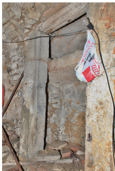
S.01_03. Západní stěna, otvor niky, pohled od severovýchodu.
