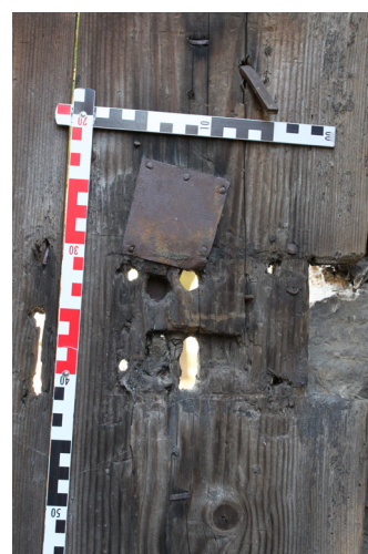
P.01_14. Vrata V 1 P.01_01, detail otisku po krabicovém zámku, pohled od severu.
