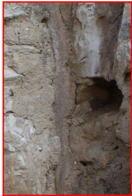
E.01_23. Jižní průčelí jižního traktu, trojúhelná plenta, detail zabíhajících omítek (E.01_F), pohled od jihovýchodu.
