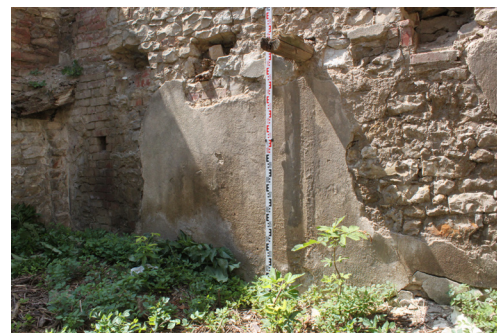
P.06_05. Západní stěna, jižní část, pohled od severovýchodu.
