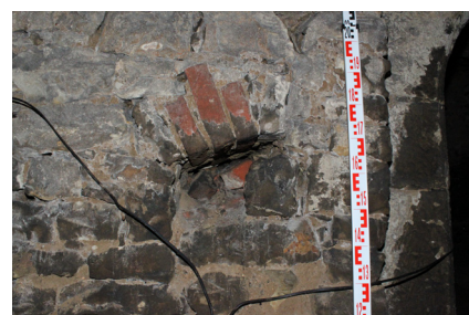
S.05_09. Severní stěna, detail niky západně od portálu, pohled od jihozápadu.
