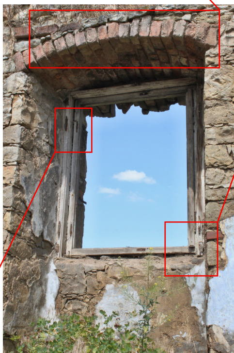
1.06_12. Severní stěna, okenní otvor O 14 1.06_01, pohled od jihu.
