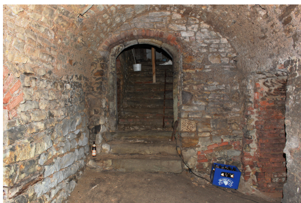
S.02_01. Jižní stěna, pohled od severu.
