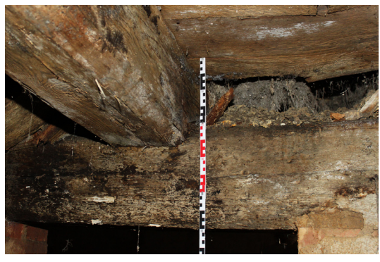
P.03_16. Strop, detail uložení stropních trámů a průvlatku, pohled od západu.
