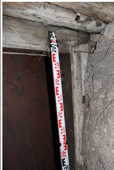
P.03_15. Vstupní otvor D 1 P.02_02, detail trámové stojky se stěžeji závěsu, pohled od severozápadu.
