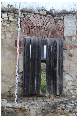
E.01_26. Jižní průčelí jižního traktu, okenní otvor O 10 1.04_02, pohled od jihu.
