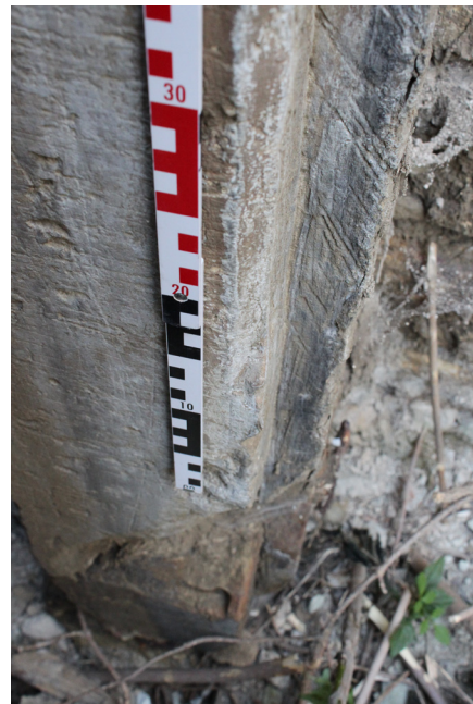
P.012_31. Portál P 2 102_01, severní stojka, detail pozůstatku náběžného štítku, pohled od jihovýchodu.
