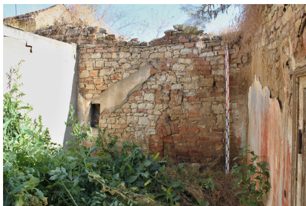
1.03_16. Severní stěna, pohled od jihu.
