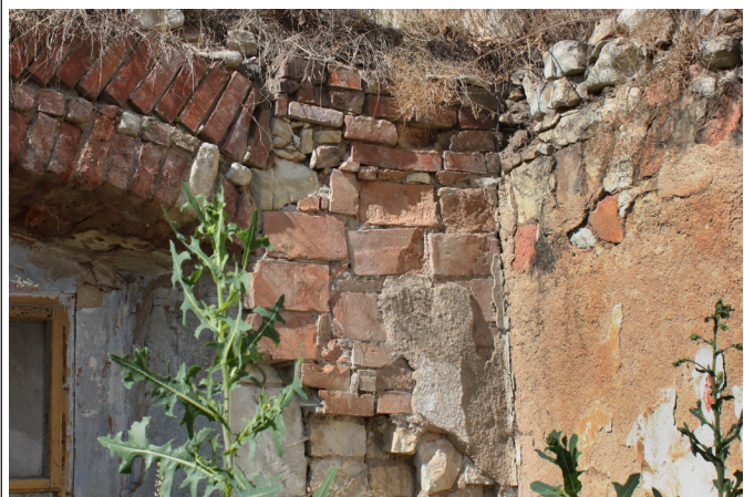
1.04_07. Jižní stěna, dozdivka z cihel různých formátů západně od okna (1.04_D), pohled od severu.
