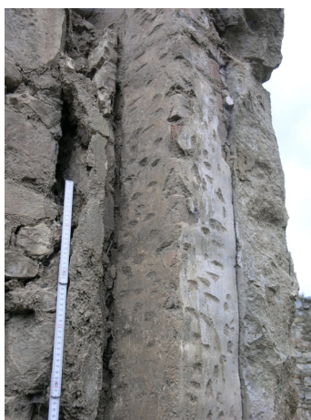
1.06_07. Jižní stěna, situace 1.06_C , pohled od severozápadu.
