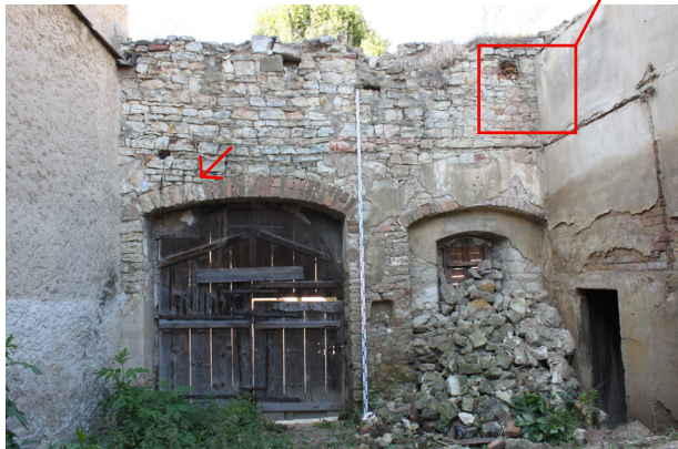
P.01_01. Jižní stěna, vrata V 1 P.01_01 (šipkou označena část klenby dozděná kamenem, P.01_A) a okno O 1 P.01_01, pohled od severu.
