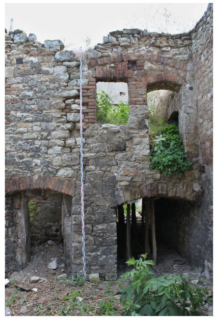
E.03_03. Jižní část západního průčelí severního traktu, pohled od západu.
