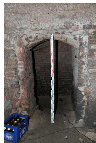
S.02_04. Západní stěna, detail vstupu, pohled od východu.
