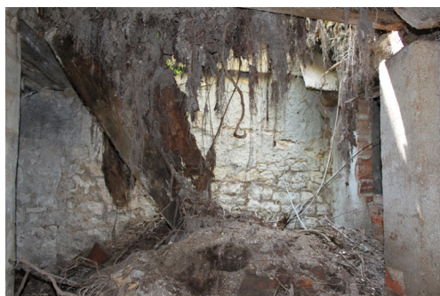
P.03_01. Jižní stěna, východní část, pohled od severu.
