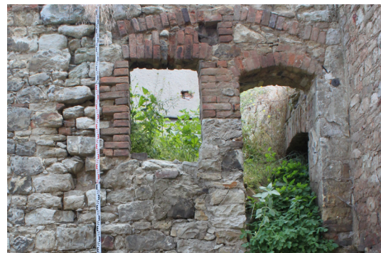
1.05_04. Západní stěna, vstupní otvor D 8 1.05_01 a okenní otvor O 11 1.05_01, nad otvory cihelný vylehčovací oblouk ( 1.05_B ), pohled z exteriéru od západu.
