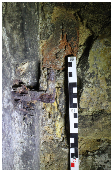
S.01_10. Severní stěna, detail horní stěžeje na východní straně vstupu do S.02, pohled od jihozápadu.
