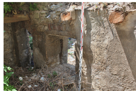
P.05_02. Západní stěna, vstupní a okenní otvor, pohled od severovýchodu.
