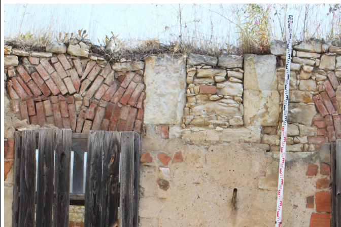
1.04_10. Jižní stěna, druhotně použité kamenné ostění oken (1.04_E), pohled na situaci z exteriéru od jihu.
