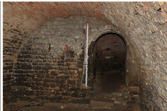
S.05_05. Severní stěna, pohled od jihu.
