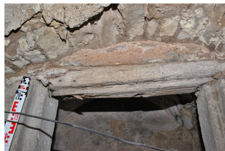
S.01_04. Západní stěna, trémový překlad nad otvorem niky v západní stěně (S.01_A), pohled od severovýchodu.
