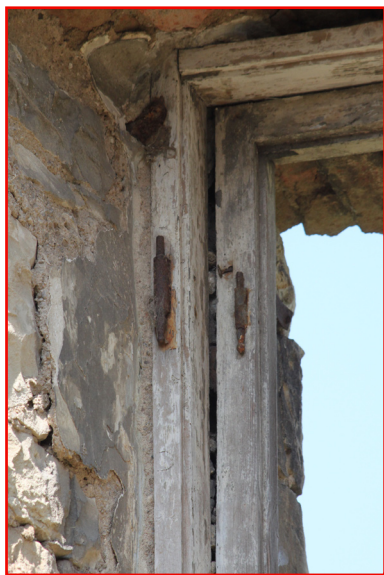
1.06_14. Severní stěna, okenní otvor O 14 1.06_01, detail horních závěsů západních křídel, pohled od jihu.
