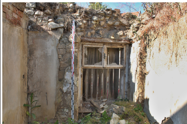
1.02_01. Jižní stěna, pohled od severu.
