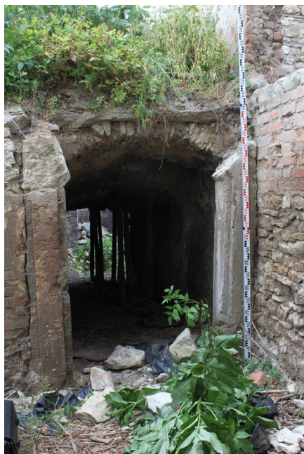
P.01_21. Portál P 2 102_01, stav v roce 2013, celkový pohled od východu.
