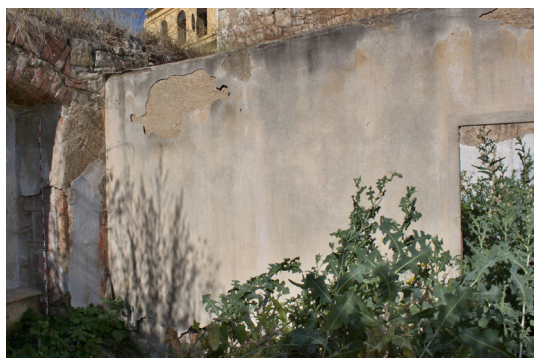
1.03_14. Západní stěna, jižní část, pohled od severovýchodu.
