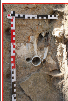
1.01_02. Jižní stěna, dochované vyústěními elektroinstalace (1.01_A), detail, pohled od severu.
