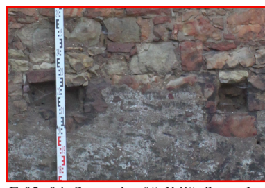
E.02_04. Severní průčelí jižního traktu, kapsy pro zavázání nosných trámů pavlače (E.02_A), pohled od severu.
