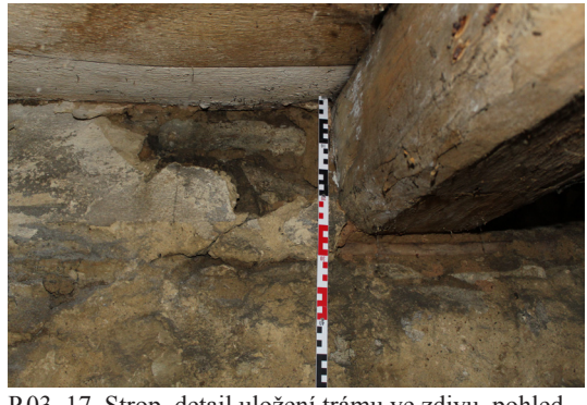
P.03_17. Strop, detail uložení trámu ve zdivu, pohled od východu.
