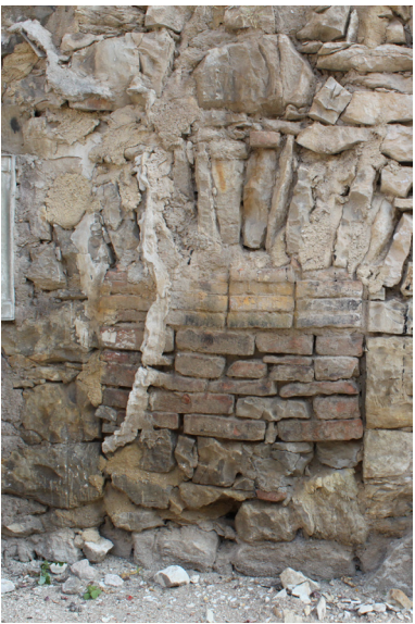
E.01_20. Jižní průčelí jižního traktu, zazděný vnější líc okenního otvoru O 4 P.03_01 (E.01_D), pohled od jihu.
