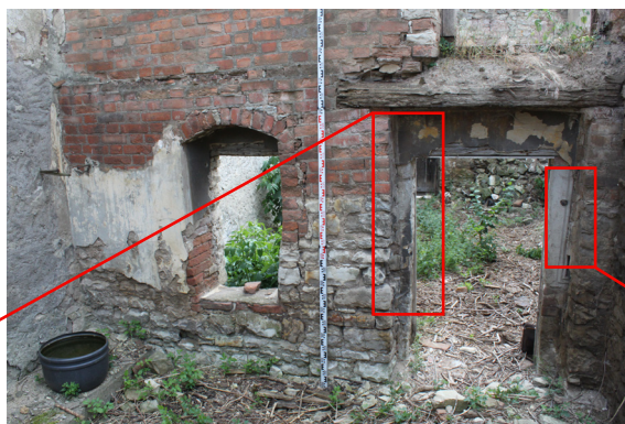
P.07_01. Jižní stěna, pohled od severu.
