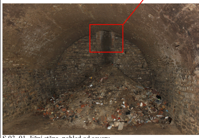
S.03_01. Jižní stěna, pohled od severu.
