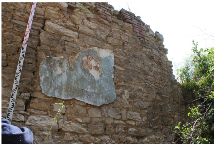
1.05_20. Východní stěna, jižní část, pohled od severozápadu.
