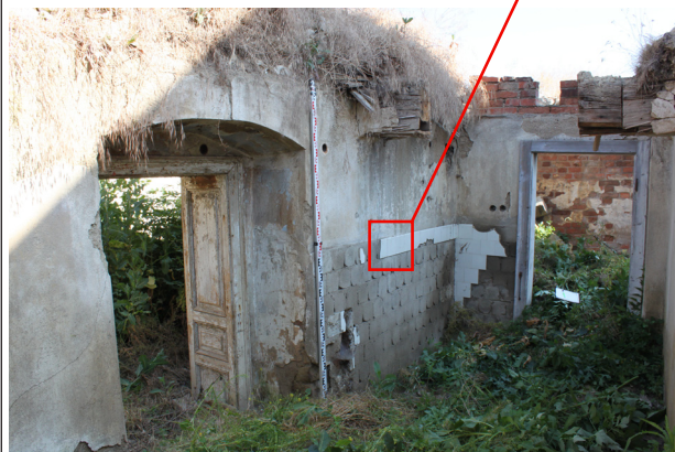
1.02_07. Západní stěna, severní část se zbytky obkladů (1.02_B), pohled od jihovýchodu.
