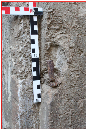
102_28. Portál P 2 102_01, severní stojka, detail stěžeje, pohled od východu.
