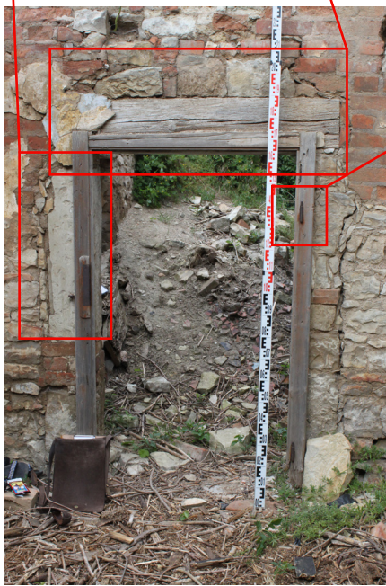
P.01_36. Severní stěna, dveře D 2 P.01_01, detail rubové strany druhotně použitého ostění portálu, pohled od jihu.
