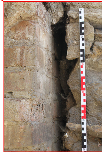
P.07_05. Jižní stěna, spára mezi jižní a západní stěnou (P.07_B), pohled od severovýchodu.
