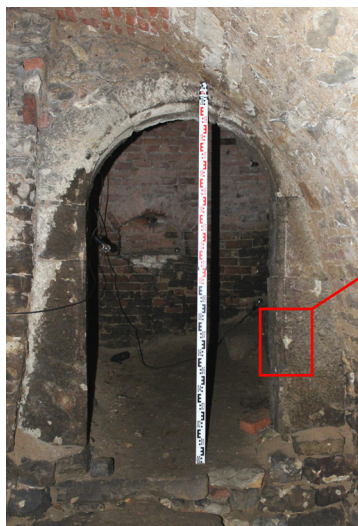
S.05_06. Severní stěna, portál P 1 S.05_01, lícová strana, pohled od jihu.
