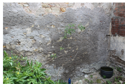
P.07_13. Východní stěna, jižní část, pohled od severozápadu.
