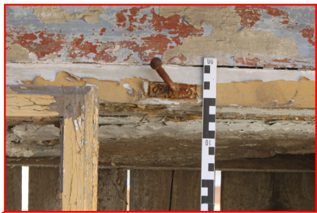
1.03_11. Jižní stěna, okenní otvor O 10 1.03_01, detail půlobrtlíku, pohled od severu.
