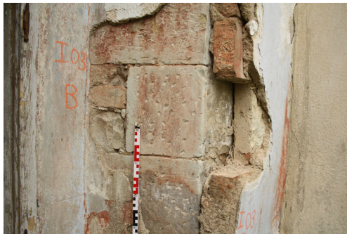
1.03_07. Jižní stěna, okenní otvor O 10 1.03_01, západní špaleta, detail špalety a cihelné plenty 1.03_B, pohled od severovýchodu.
