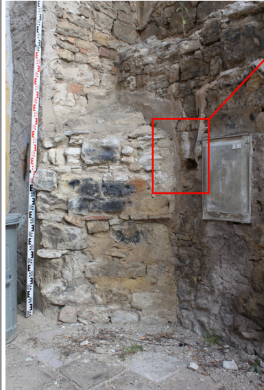
E.01_22. Jižní průčelí jižního traktu, trojúhelná plenta na západní konci průčelí, pohled od jihovýchodu.
