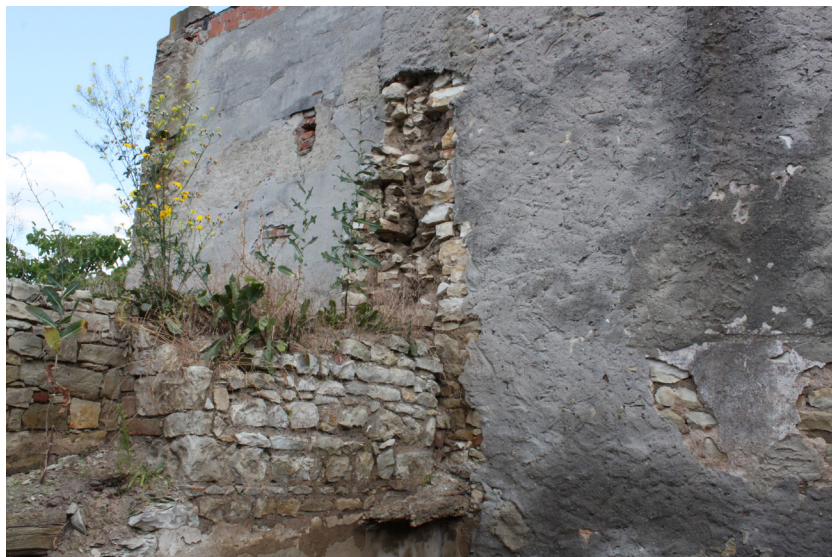
1.07_06. Východní stěna, severní část, pohled od jihozápadu.
