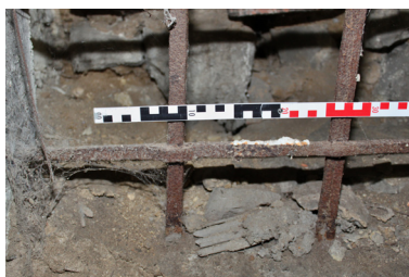
P.03_05. Jižní stěna, okno O 4 P.03_01, detail mříže, pohled od severu.
