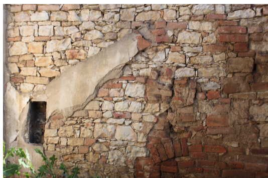
1.03_17. Severní stěna, západní část s komínovým tělesem (1.03_E) pohled od jihu.
