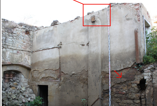
P.01_15. Západní stěna, šipkou označen otisk po schodišti na pavlač (P.01_D), celkový pohled od severovýchodu.
