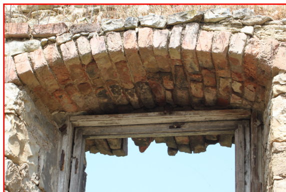
1.06_13. Severní stěna, okenní otvor O 14 1.06_01, detail záklenku, pohled od jihu.
