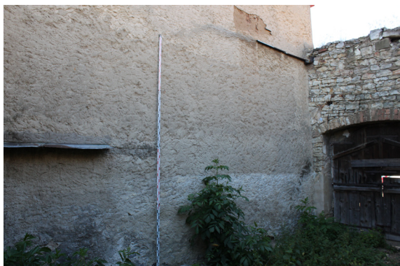
P.01_49. Východní stěna, jižní část, pohled od severozápadu.
