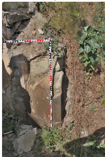
1.01_03. Východní stěna, fragment jižní stojky portálu P 4 1.01_01 (1.01_B), pohled od severovýchodu.
