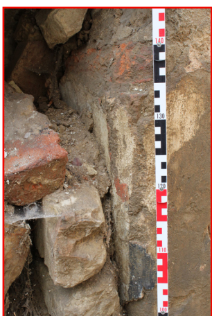
P.01_19. Západní stěna, detail omítky s nátěrem zabíhající do zdiva, pohled od východu.
