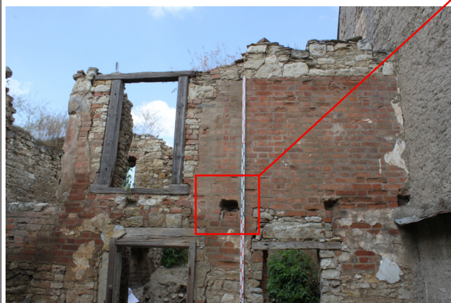
P.01_45. Severní stěna, východní část, pohled od jihu.
