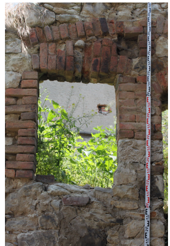
1.05_08. Západní stěna, okenní otvor O 11 1.05_01, pohled od východu.
