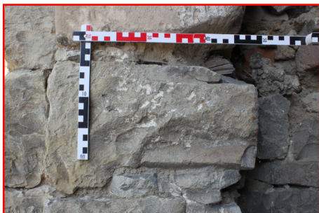
E.01_07. Jižní průčelí jižního traktu, průjezd s vraty V 1 P.01_01, západní stojka, detail druhotně použitého okenního ostění (E.01_A), pohled od jihu.
