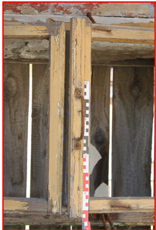
1.03_09. Jižní stěna, okenní otvor O 10 1.03_01, detail madla, pohled od severu.
