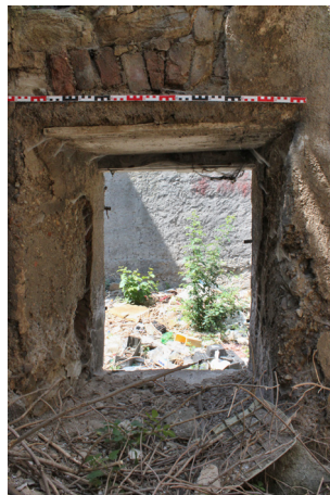
P.05_05. Západní stěna, lícová strana okenního otvoru O 6 P.05_01, pohled od východu.
