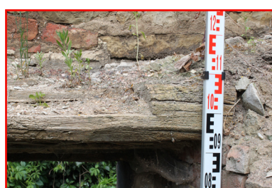
P.07_09. Severní stěna, okenní otvor O 8 P.07_01 s přímým trámovým překladem (P.07_C), detail, pohled od jihu.
