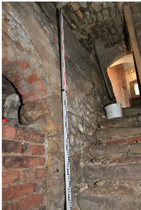
S.01_05. Východní stěna, na levé straně nika (S.01_B), pohled od severozápadu.
