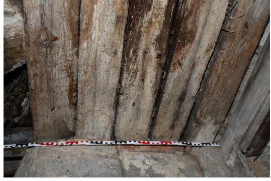
P.03_13. Vstupní otvor D 1 P.02_02, trámový překlád špalety (P.03_D).
