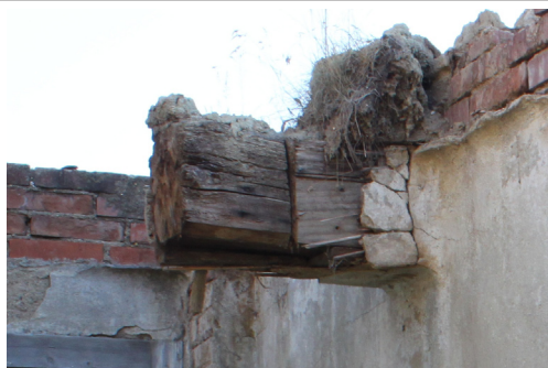
1.02_15. Detail odřezaného průvlastku trámového stropu síně na východní stěně s obedněním, pohled od východu.
