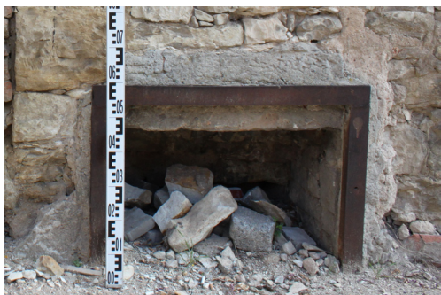
E.01_24. Jižní průčelí jižního traktu, sklepní okno do místnosti S.05, pohled od jihu.
