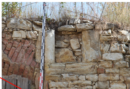
E.01_29. Jižní průčelí jižního traktu, kamenné ostění pod korunou zdiva západně od okenního otvoru O 10 1.03_01 (E.01_I), pohled od jihu.
