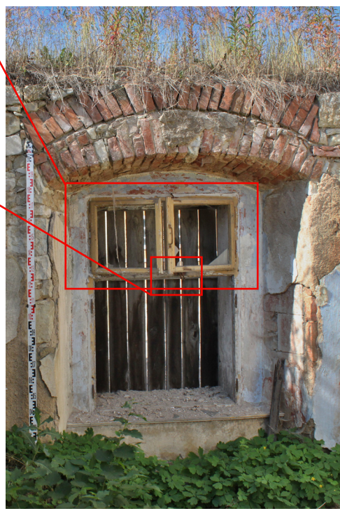
1.03_02. Jižní stěna, okenní otvor O 10 1.03_01, pohled od severu.
