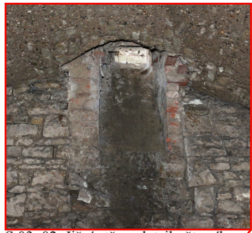
S.03_02. Jižní stěna, detail větracího okénka, pohled od severu.
