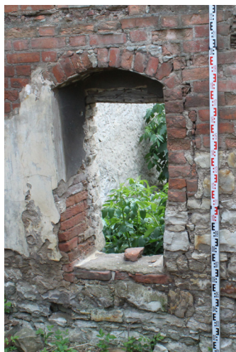
P.01_41. Severní stěna, okno O 3 P.01_01, pohled od severu.
