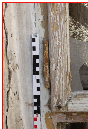
1.02_04. Jižní stěna, okenní otvor O 9 1.02_01, detail závěsu, pohled od severu.
