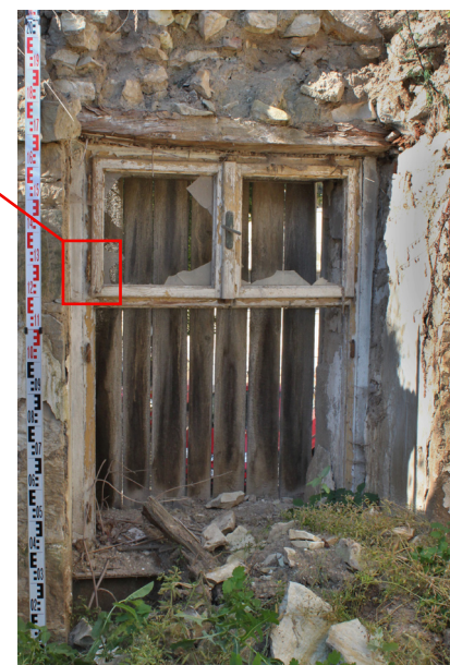
1.02_02. Jižní stěna, okenní otvor O 9 1.02_01, pohled od severu.
