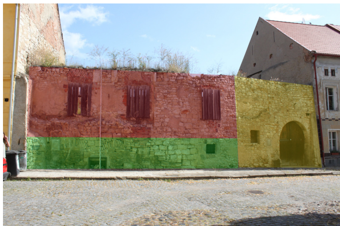
E.01_03. Jižní průčelí jižního traktu, stav v roce 2013, pohled od jihu.
