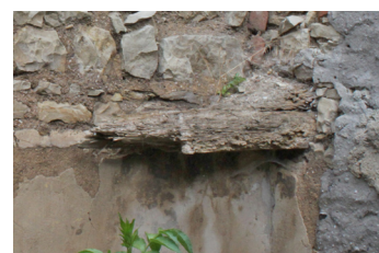
P.07_11. Severní stěna, východní část se zbytkem stropního trámu (P.07_E), pohled od jihozápadu.
