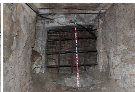
P.03_03. Jižní stěna, okno O 4 P.03_01, pohled od severu.
