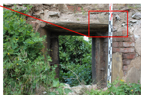
P.07_08. Severní stěna, okenní otvor O 8 P.07_01 s přímým trámovým překladem (P.07_C), pohled od jihu.
