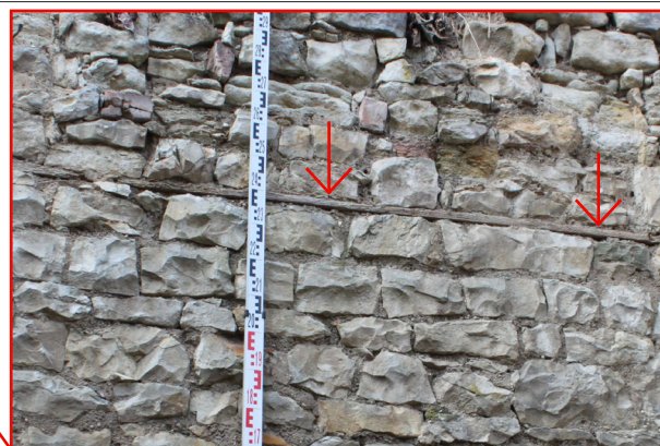
1.06_10. Západní stěna, detail zazděného prkna (1.06_D), pohled od východu.
