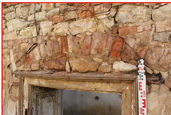
1.03_23. Východní stěna, detail vylehčovacího oblouku (1.03_G) pohled od jihozápadu.
