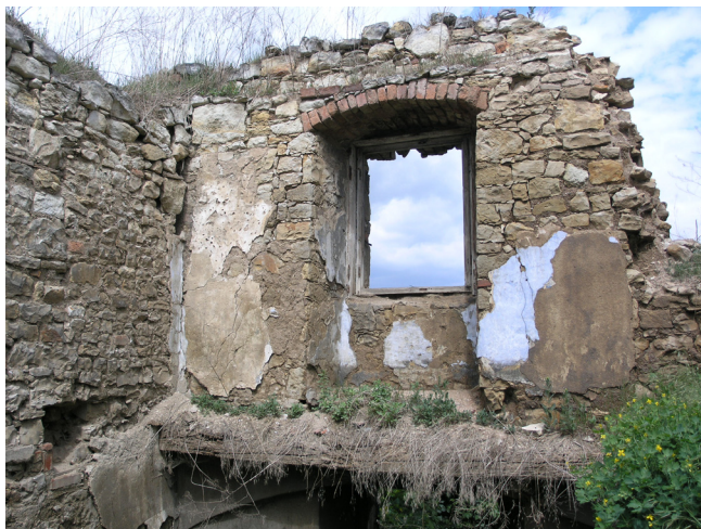
1.06_11. Severní stěna s okenním otvorem O 14 1.06_01, pohled od jiho-východu.
