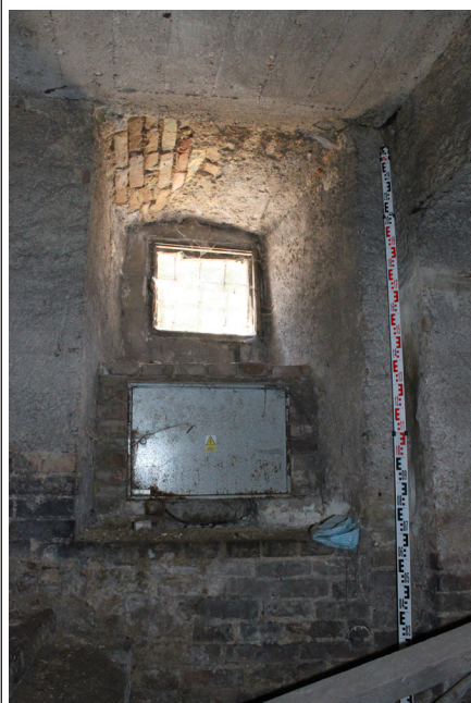
P.02_01. Jižní stěna, pohled od severu.
