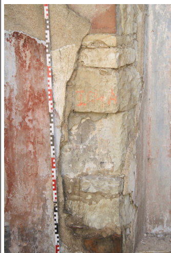
1.04_02. Jižní stěna, okenní otvor O_{10} 1.04_01, východní špaleta s náleзовou situací 1.04_A, pohled od severozápadu.
