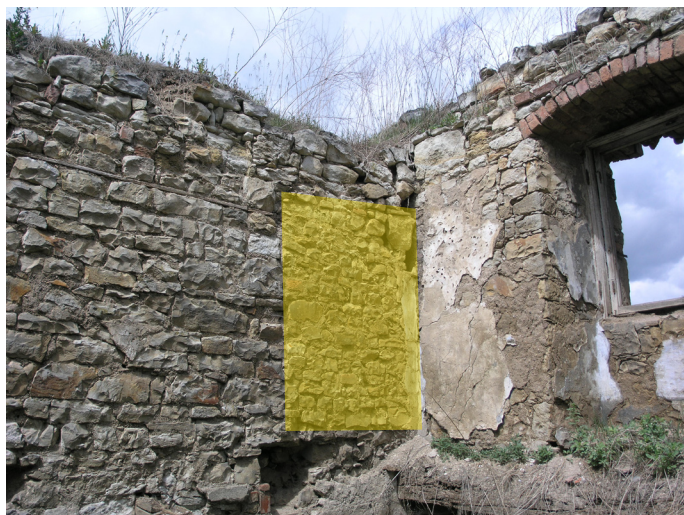
1.06_09. Západní stěna, severní část, barevně vyznačený zazděný vstup do 1.05, pohled od východu.
