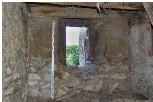
P.03_07. Severní stěna, západní polovina s okenním otvorem O 5 P.03_01, pohled od jihu.
