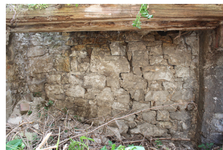
P.05_01. Jižní stěna, pohled od severu.
