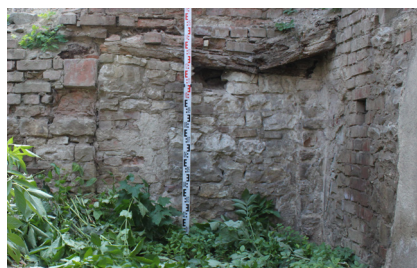
P.04_10. Severní stěna, portál P 3 P.04_01, rubová strana portálové niky, pohled od severu.
