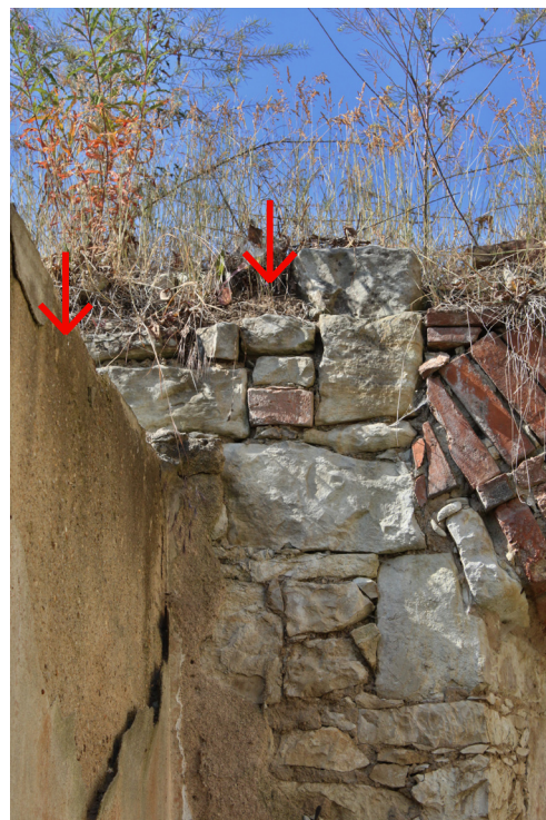
1.04_08. Jižní stěna, druhotně použité kamenné ostění oken (1.04_E), pohled od severu z místnosti 1.04.
