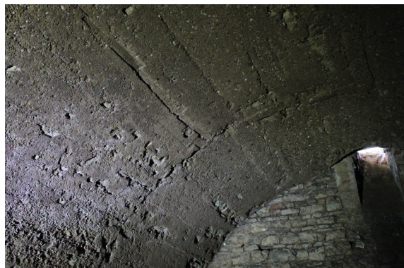
S.03_09. Klenba, detail otisku šalovacích prken, ( S.03_B ), pohled od severozápadu.
