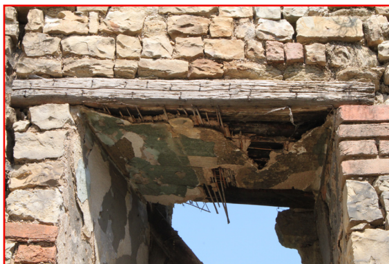
1.05_16. Severní stěna, okenní otvor O 13 1.05_01, detail přímého překladu, pohled od jihu.
