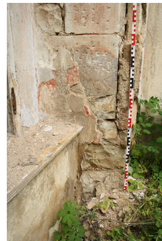
1.03_06. Jižní stěna, okenní otvor O 10 1.03_01, západní špaleta s náleзовou situací I.03_B a I.03_C, pohled od severovýchodu.
