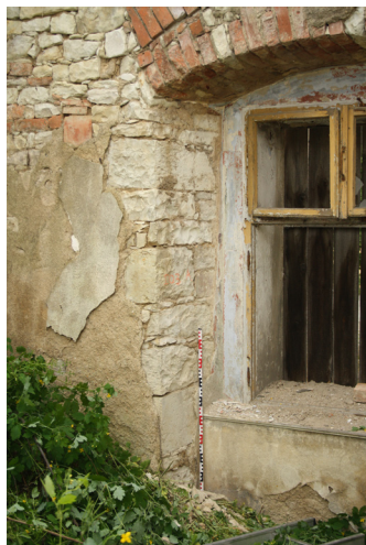
1.03_03. Jižní stěna, okenní otvor O 10 1.03_01, východní špaleta s náleзовou situací I.03_A, pohled od severozápadu.
