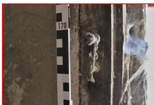
P.02_03. Jižní stěna, okno O 3 P.02_01, detail obrtlíku, pohled od severozápadu.
