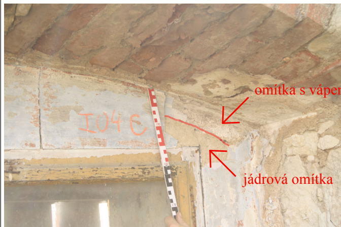
1.04_06. Jižní stěna, okenní otvor O 10 1.04_01, názorová situace 1.04_C, pohled od severovýchodu.
