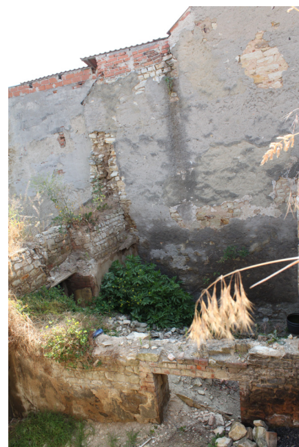
1.07_04. Západní stěna, pohled od východu.
