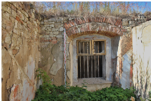
1.03_01. Jižní stěna, pohled od severu.
