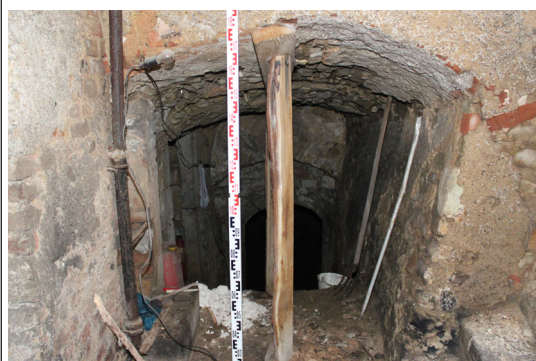
S.01_01. Vstup do prostoru schodiště do sklepa (S.01) z místnosti P.02, pohled od jihu.
