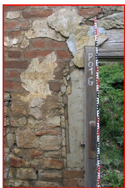
P.01_36. Severní stěna, dveře D 2 P.01_01, detail rubové strany druhotně použitého ostění portálu, pohled od jihu.
