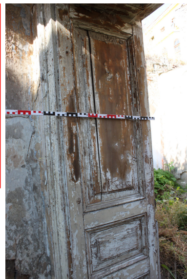
1.03_22. Vstupní otvor D 7 1.03_01, detail deštění, pohled od jihozápadu.
