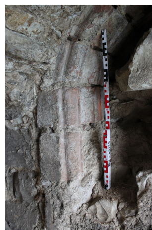
P.04_09. Severní stěna, portál P 3 P.04_01, detail západní části oblouku, pohled od jihu.
