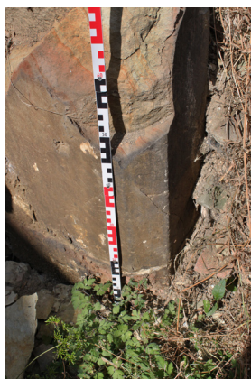
1.01_04. Východní stěna, detail fragmentu jižní stojky portálu P 4 1.01_01, pohled od severovýchodu.
