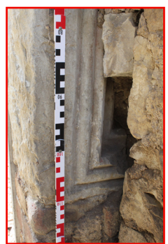
P.01_39. Severní stěna, dveře D 2 P.01_01, detail spodní části lícové strany druhotně použitého ostění portálu, pohled od severovýchodu.
