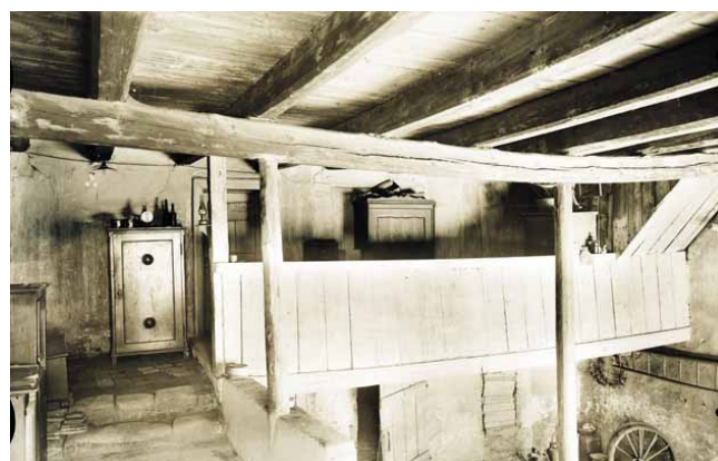
P.01_44. Vzhled severní stěny před přestavbou v roce 1935 (Muzeum Žatec inv. č. Fn-52), pohled od jihu.
