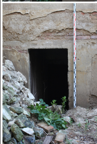
P.01_17. Západní stěna, detail vstupního otvoru s dveřmi D 1 P.01_01, pohled od východu.
