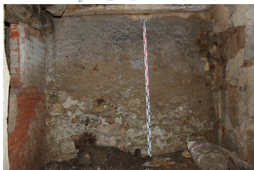
P.03_08. Severní stěna, východní polovina, pohled od jihu.
