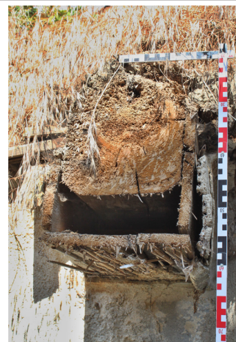
1.02_13. Detail odřezaného průvlastku trámového stropu síně na západní straně(1.02_D) s obedněním, pohled od východu.
