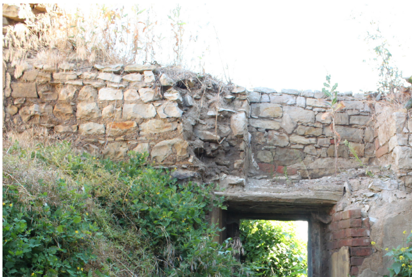
1.07_05. Severní stěna, dochované pozůstatky v západní části, pohled od jihu.
