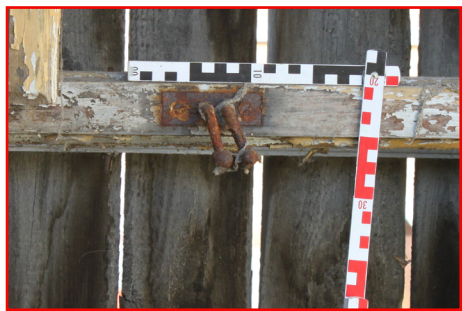
1.03_12. Jižní stěna, okenní otvor O 10 1.03_01, detail půlobrtlíků pro jištění spodních a horních křídel, pohled od severu.
