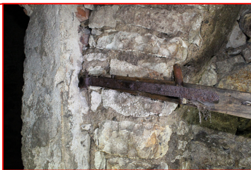
S.03_05. Západní stěna, detail závěsu zavěšeného ve stěžeji ukotvené v kameni ( S.03_A ), pohled od jihovýchodu.
