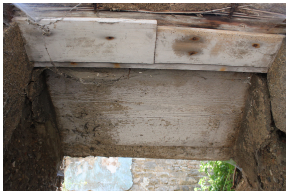
P.05_06. Západní stěna, okenní otvor O 6 P.05_01, prkenný podhled, pohled od východu.
