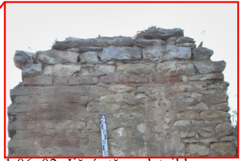
1.06_02. Jižní stěna, detail koruny zdiva ( 1.06_B ), pohled od severu.
