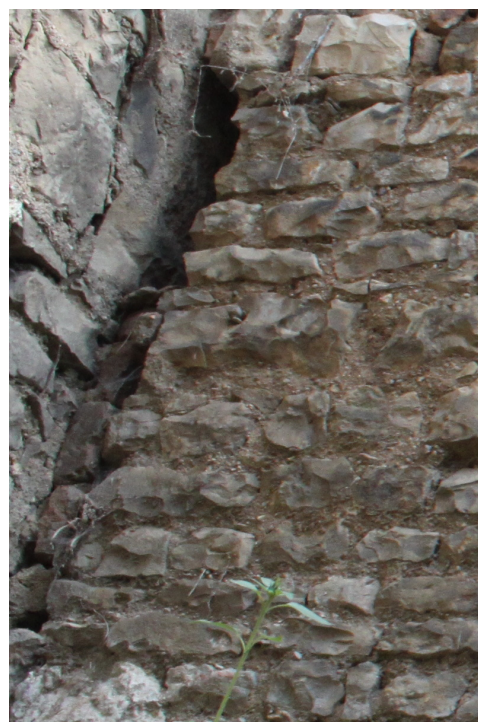
1.05_21. Východní stěna, severní část, spára mezi severní stěnou a zdivem zazděného vstupu, pohled od jihozápadu.
