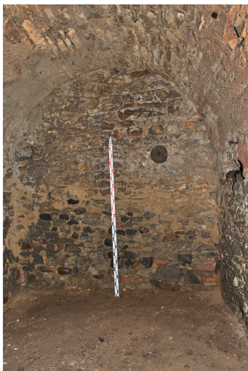
S.02_05. Severní stěna, pohled od jihu.
