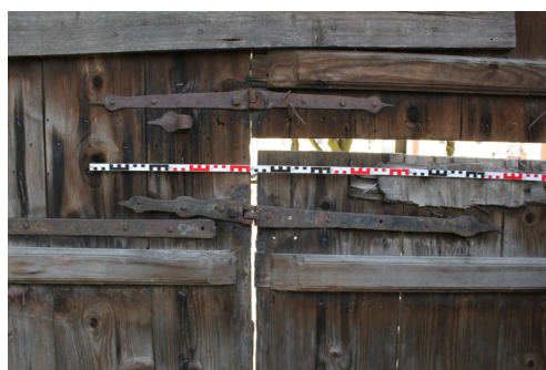
P.01_13. Vrata V 1 P.01_01, detail zavěšení spodní a horní části západní poloviny, pohled od severu.
