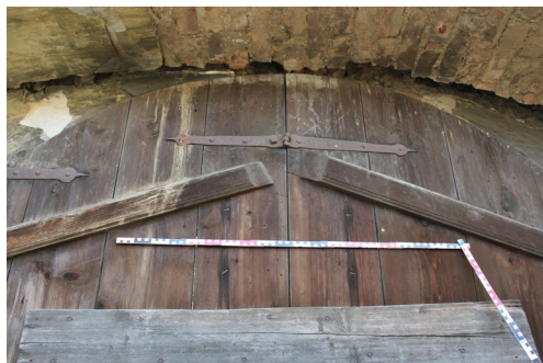
P.01_09. Vrata V 1 P.01_01, detail ukončení a horních šikmých svlaků, pohled od severu.
