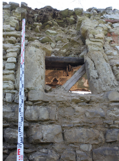
E.04_05. Severní průčelí severního traktu, ostění okenního otvoru O 13 1.05_01, pohled od severu.
