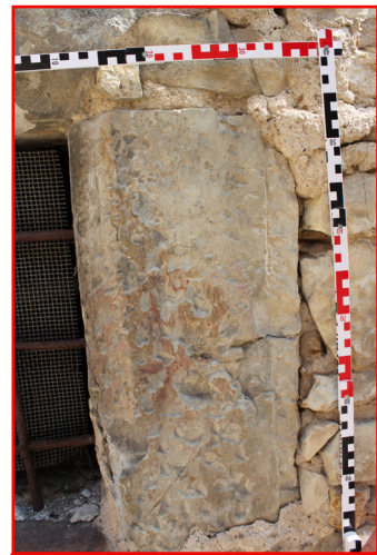
E.01_16. Jižní průčelí jižního traktu, okenní otvor O 3 P.02_01, detail východní stojky ostění, pohled od jihu.
