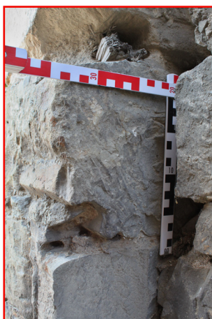
E.01_08. Jižní průčelí jižního traktu, průjezd s vraty V 1 P.01_01, západní stojka, detail druhotně použitého okenního ostění (E.01_A), pohled od severu.
