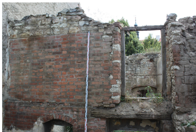
1.07_01. Jižní stěna, pohled od severu.
