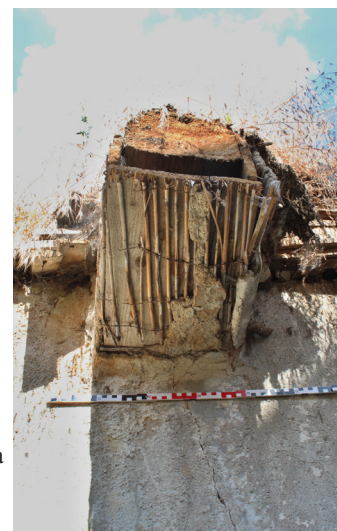
1.02_14. Detail odřezaného průvlastku trámového stropu síně na západní straně(1.02_D) s obedněním, pohled od východu.
