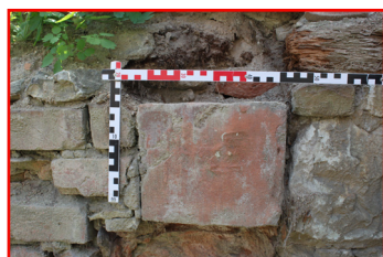
P.06_03. Jižní stěna, detail druhotně použité tvarovky (P.06_B), pohled od severu.
