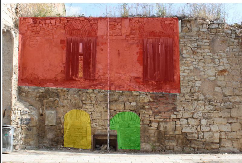
E.01_19. Jižní průčelí, barevně vyznačené zazděné okenní otvory původně osvětlující místnost P.03, nad nimi barevně zvýrazněna ustupující část zdiva v patře, pohled od jihu.
