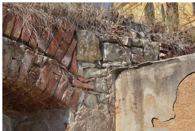
1.04_09. Jižní stěna, druhotně použité kamenného ostění oken (1.04_E), pohled od severovýchodu z místnosti 1.03.
