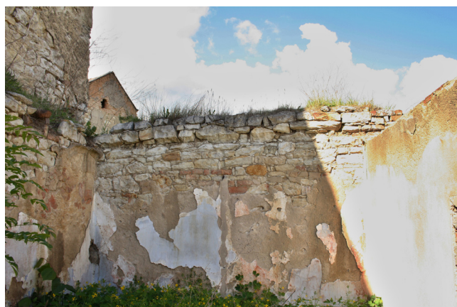
1.04_14. Severní stěna, pohled od jihu.
