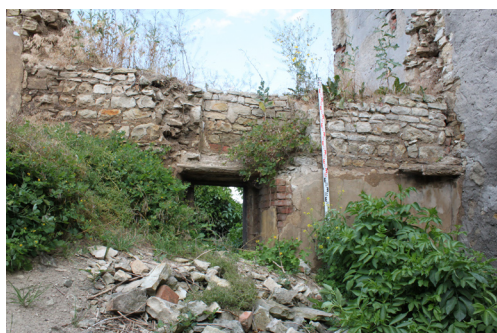
P.07_07. Severní stěna s okenním otvorem O 8 P.07_01, pohled od jihu.
