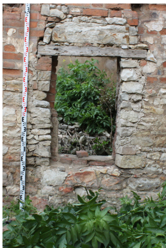
P.01_40. Severní stěna, okno O 3 P.01_01, pohled od jihu.
