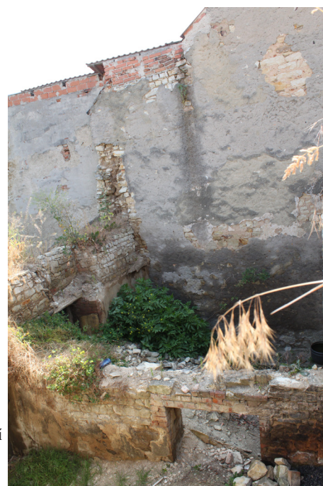
1.06_16. Východní stěna, pohled od jihozápadu.
