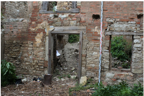
P.01_32. Severní stěna s dveřmi D 2 P.01_01 a oknem O 3 P.01_01, pohled od jihu.
