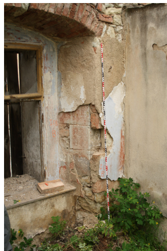
1.03_05. Jižní stěna, okenní otvor O 10 1.03_01, západní špaleta s náleзовou situací I.03_B a I.03_C, pohled od severovýchodu.
