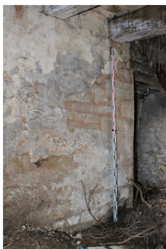
P.03_11. Východní stěna, jižní část se vstupem D 1 P.02_02, pohled od severozápadu.
