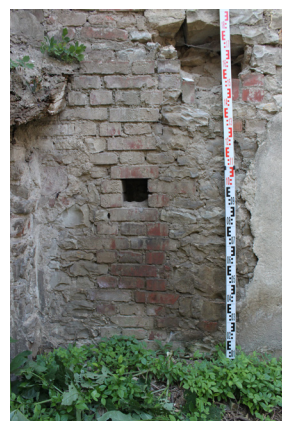
P.06_06. Západní stěna, detail zazděného vstupu do místnosti P.05, pohled od východu.
