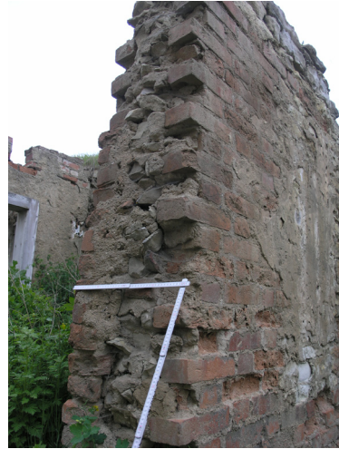
1.06_03. Jižní stěna, řez stěnou ( 1.06_A ), pohled od severovýchodu.
