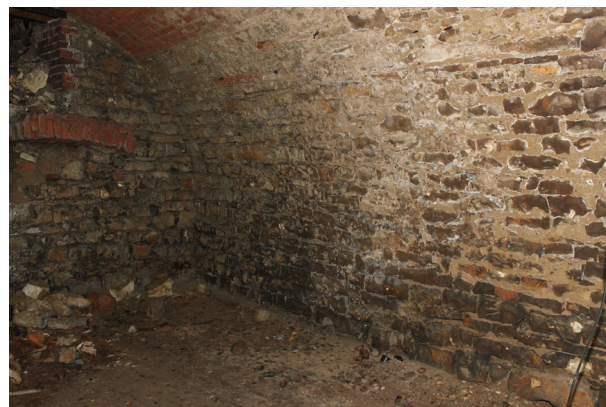
S.05_04. Západní stěna, pohled od severovýchodu.
