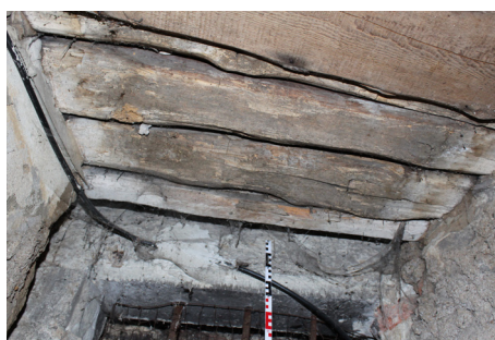
P.03_04. Jižní stěna, okno O 4 P.03_01, detail trámového překladu (P.03_A), pohled od severu.
