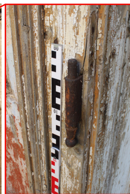
1.03_24. Vstupní otvor D 7 1.03_01 detail závěsu, pohled od jihozápadu.
