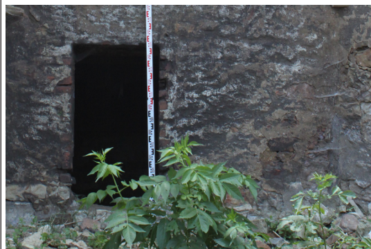
E.02_03. Severní průčelí jižního traktu, okenní otvor O 5 P.03_01, pohled od severu.
