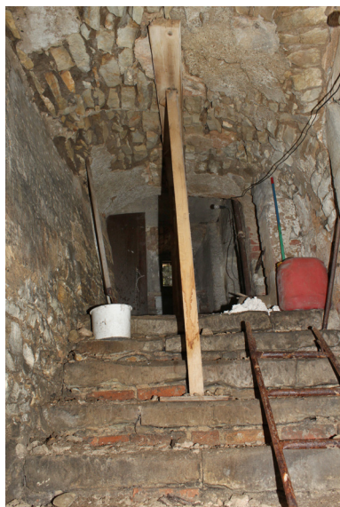
S.01_02. Pohled na klenbu schodiště od severu.
