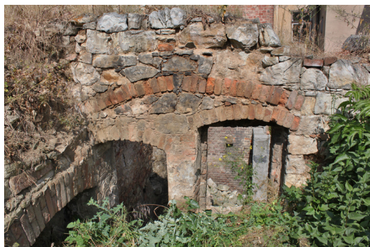
1.05_03. Západní stěna, vstupní otvor D 8 1.05_01 a okenní otvor O 11 1.05_01, nad otvory cihelný vylehčovací oblouk ( 1.05_B ), pohled od východu.
