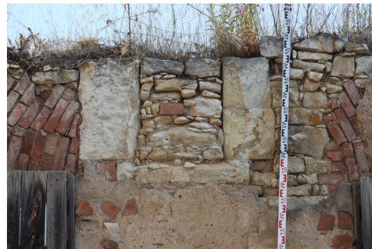
E.01_27. Jižní průčelí jižního traktu, kamenné ostění pod korunou zdiva západně od okenního otvoru O 10 1.04_02 (E.01_H), pohled od jihu.
