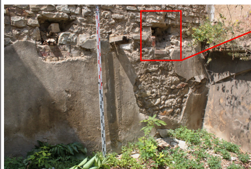
P.06_07. Západní stěna, severní část, pohled od východu.
