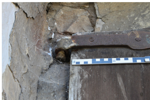
P.01_10. Vrata V 1 P.01_01, detail horního závěsu a stěžeje západní poloviny, pohled od severu.
