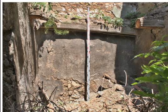
P.05_07. Severní stěna, pohled od jihu.
