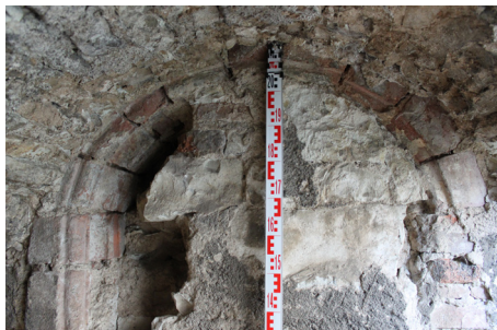
P.04_06. Severní stěna, portál P 3 P.04_01, horní část, pohled od jihu.
