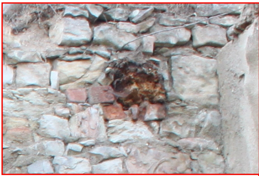
P.01_02. Jižní stěna, detail kapsy po stropním trámu (1.01_A), pohled od severu.
