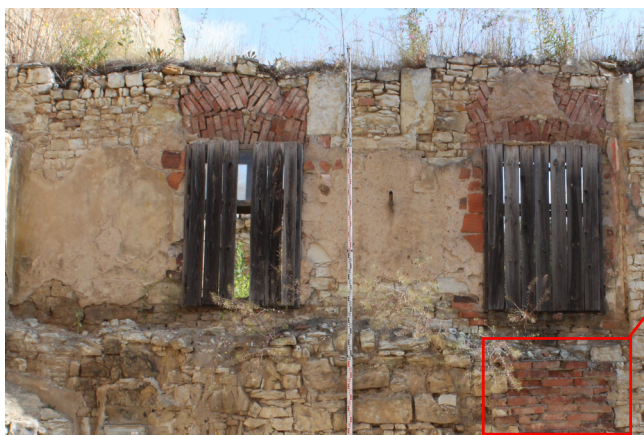
E.01_25. Jižní průčelí jižního traktu, odsazená část stěny v patře s okenními otvory O 10 1.04_02 (vlevo) a O 10 1.03_01 (vpravo), pohled od jihu.
