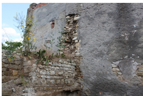
P.07_12. Východní stěna, severní část, pohled od jihozápadu.
