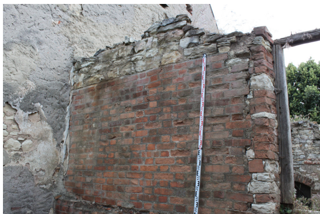
1.07_02. Jižní stěna, východní část, pohled od severozápadu.
