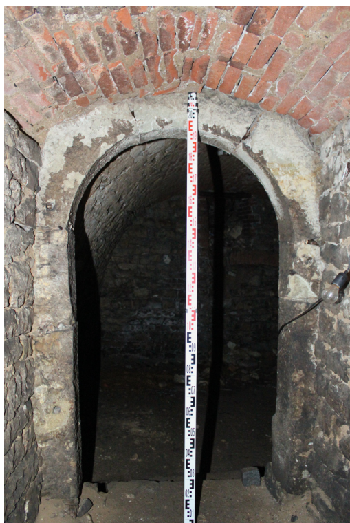
S.04_01. Jižní stěna, rubová strana portálu, pohled od jihu.
