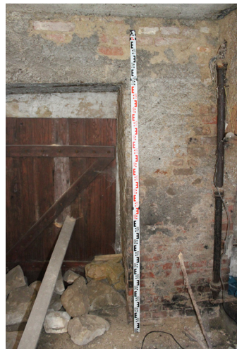
P.02_06. Západní stěna, dveře D 1 P.02_02, pohled od východu.
