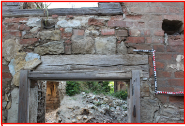
P.01_34. Severní stěna, dveře D 2 P.01_01, detail trámového překladu, pohled od jihu.
