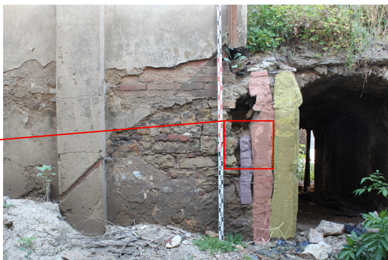
P.01_18. Západní stěna, barevně odlišeny jednotlivé druhy zdiva (P.01_E), pohled od východu.
