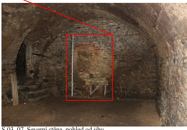
S.03_07. Severní stěna, pohled od jihu.
