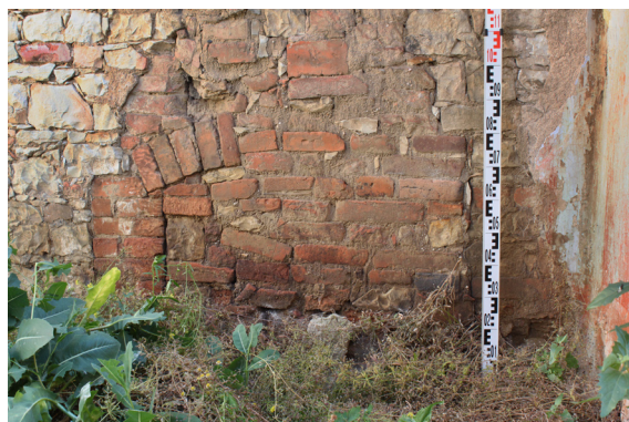
1.03_18. Severní stěna, východní část se segmentovým obloukem (1.03_F) pohled od jihu.
