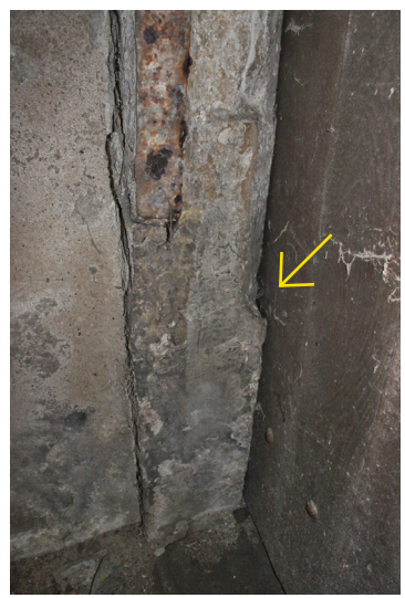
P.03_14. Vstupní otvor D 1 P.02_02, detail severní tesané portálové stojky s vyznačeným náběžním štítkem (P.03_C), pohled od jihozápadu.
