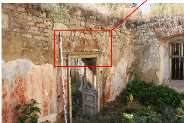
1.03_19. Východní stěna se vstupním otvorem D 7 1.03_01, pohled od severozápadu.
