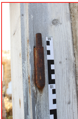
1.02_10. Severní stěna, vstupní otvor D 6 1.02_01, detail závěsu, pohled od jihu.
