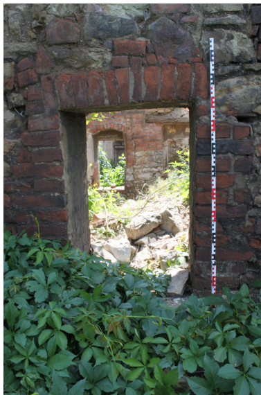
E.04_10. Severní průčelí severního traktu, okenní otvor O 8 P.07_01, pohled od severu.
