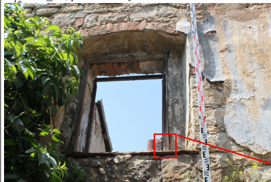
1.05_10. Západní stěna, okenní otvor O 12 1.05_01, pohled od východu.
