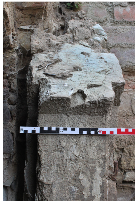
P.01_30. Portál P 2 102_01, styčná plocha severní stojky a klenebního oblouku, pohled od jihu.
