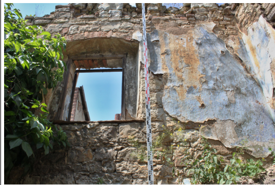
1.05_09. Západní stěna s okenním otvorem O 12 1.05_01, pohled od východu.
