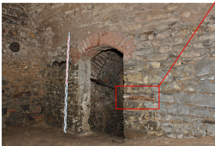
S.02_06. Východní stěna se vstupním otvorem do místnosti S.03, pohled od jihozápadu.
