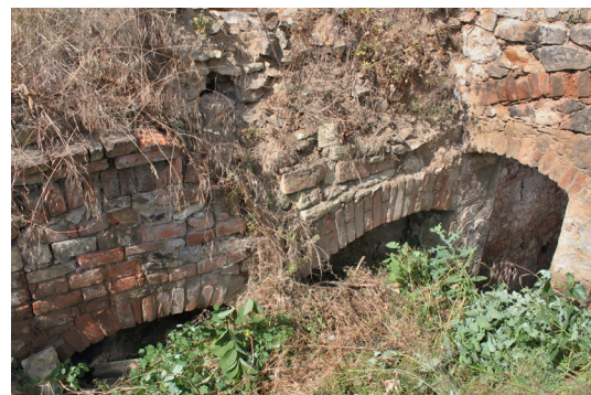
1.05_01. Jižní stěna, segmentové záklenky ( 1.05_A ), pohled od severovýchodu.
