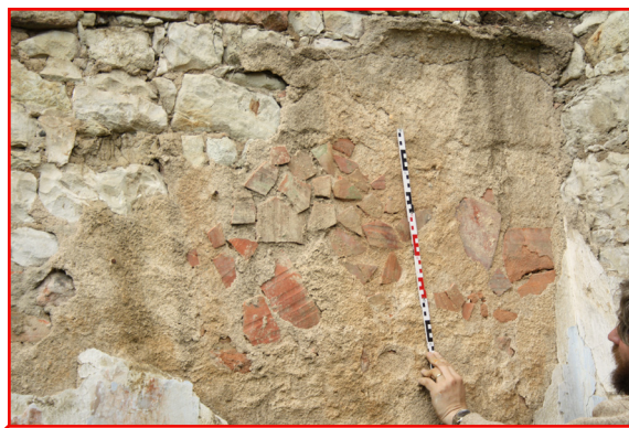
1.04_13. Západní stěna, druhotně použité úlomky bobrovek (1.04_E), pohled od východu.
