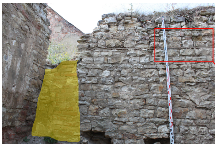
1.06_08. Západní stěna, jižní část, barevně vyznačená část vyzděná z cihel, pohled od východu.
