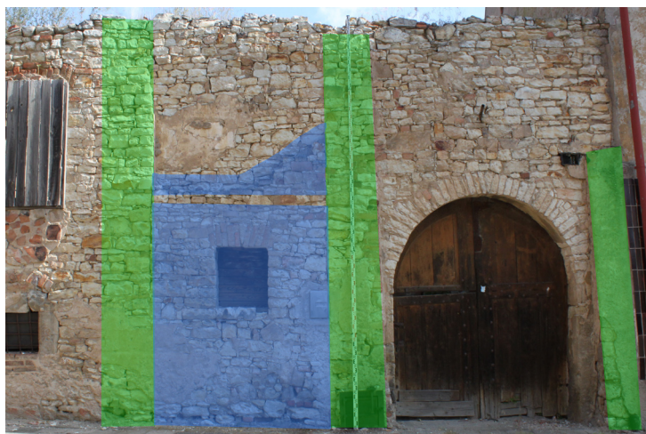
E01_04. Jižní průčelí jižního traktu, barevně zvýrazněné zdivo opěráků a kamenné plenty, pohled od jihu.
