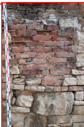
E.01_30. Jižní průčelí jižního traktu, detail cihelné zazdívký pod okenním otvorem O 10 1.03_01 (E.01_G), pohled od jihu.
