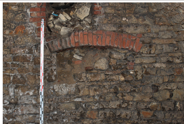
S.05_02. Jižní stěna, cihelný záklenek v západní části stěny, pohled od severu.
