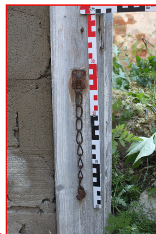
1.02_11. Severní stěna, vstupní otvor D 6 1.02_01, detail bezpečnostního řetízku, pohled od jihu.
