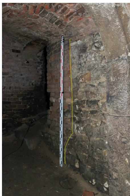
S.04_05. Východní stěna, žlutou čarou vymezen předěl mezi kamenným a cihelným zdivem (S.04_B), pohled od jihozápadu.
