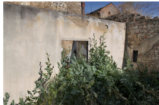
1.03_13. Západní stěna, severní část, pohled od jihovýchodu.
