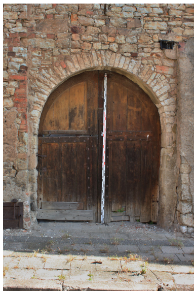
P.01_07. Vrata V 1 P.01_01, pohled na lícovou stranu od jihu.
