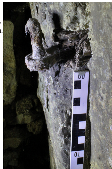
S.01_09. Severní stěna, detail horní stěžeje na západní straně vstupu do S.02, pohled od východu.
