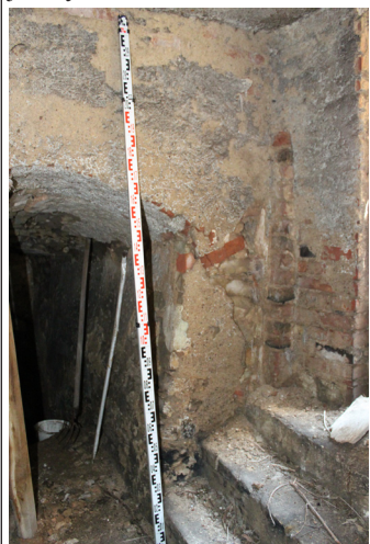
P.02_08. Severní a východní stěna, pohled od jihozápadu.
