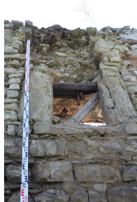
1.05_17. Severní stěna, okenní otvor O 13 1.05_01, pohled z exteriéru od jihu.
