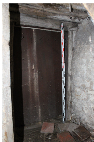
P.03_12. Východní stěna, jižní část se vstupem D 1 P.02_02, pohled od severozápadu.
