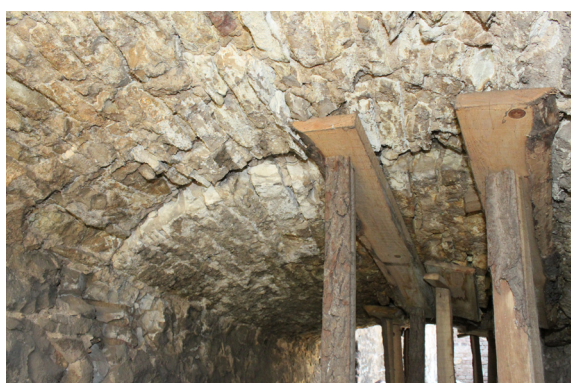
P.04_11. Technologická spára v klenbě (P.04_A), pohled od východu.
