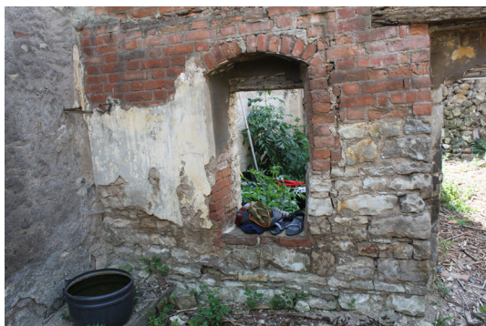
P.07_03. Jižní stěna, východní část s okenním otvorem O 3 P.01_01, pohled od severu.
