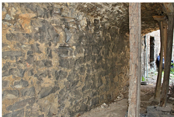
P.04_01. Jižní stěna, pohled od severovýchodu.
