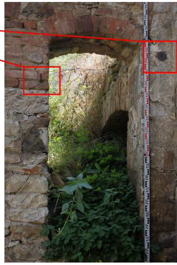
1.05_05. Západní stěna, vstupní otvor D 8 1.05_01, pohled od západu.
