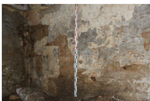
P.03_09. Východní stěna, pohled od jihozápadu.
