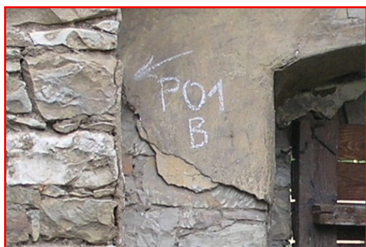
P.01_05. Jižní stěna, náleзовá situace P.01_B, pohled od severu.
