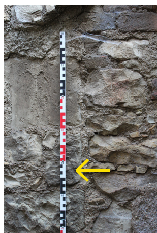
P.05_10. Východní stěna, spára mezi špaletou a výplní zazděného vstupu do P.06, pohled od východu.
