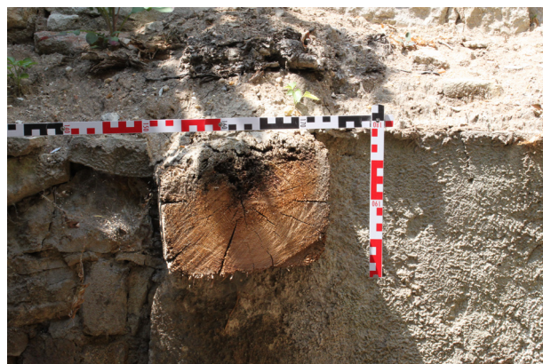
P.05_11. Západní stěna, detail odřezaného stropního trámu, pohled od východu.
