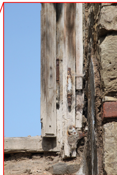
1.06_15. Severní stěna, okenní otvor O 14 1.06_01, detail spodních závěsů východních křídel a lavičnicku, pohled od jihu.
