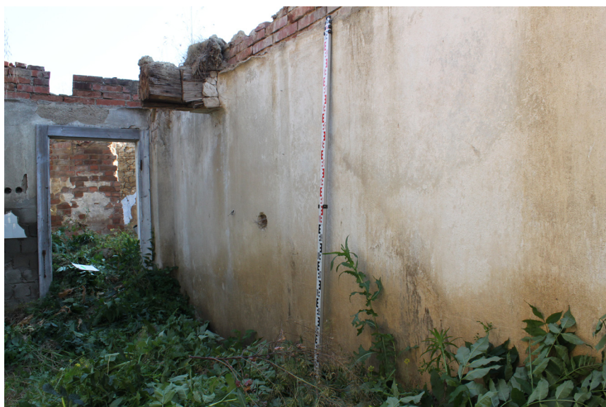
1.02_12. Východní stěna, pohled od jihozápadu.
