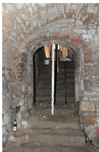
S.02_02. Jižní stěna, detail vstupu se schodištěm, pohled od severu.
