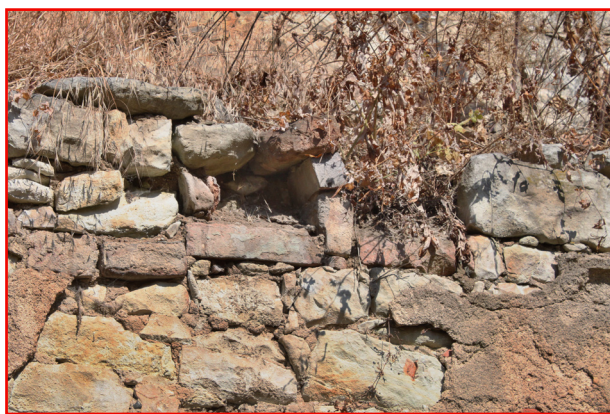
1.04_12. Západní stěna, kapsa po stropních trámech (1.04_F), pohled od jihovýchodu.
