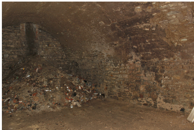
S.03_03. Západní stěna, pohled od severovýchodu.
