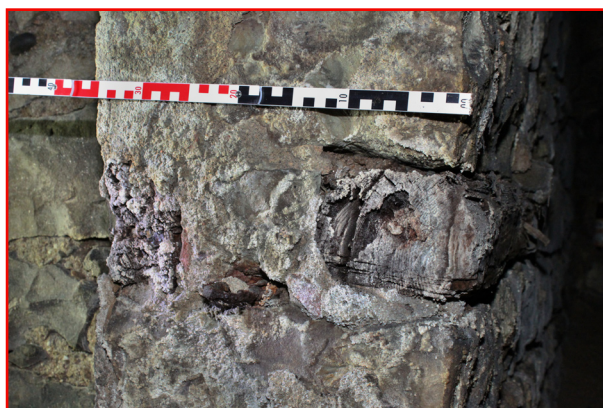
S.02_07. Východní stěna, detail zazděného trámků (S.02_E) v jižní špaletě vstupního otvoru do místnosti S.03, pohled od severozápadu.
