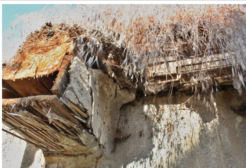
1.02_16. Detail odřezaného průvlastku trámového stropu síně na západní straně(1.02_D) s obedněním, pohled od východu.
