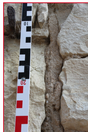
E.01_10. Jižní průčelí jižního traktu, detail omítky ve spáře mezi zdívkou opěráku a plentou (E.01_B), pohled od jihu.
