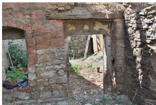
P.07_02. Jižní stěna, západní část se vstupním otvorem D 2 P.01_01, pohled od severu.
