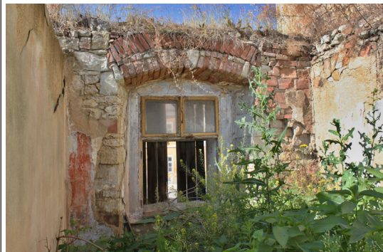
1.04_01. Jižní stěna a okenní otvor O_{10} 1.04_01, pohled od severu.
