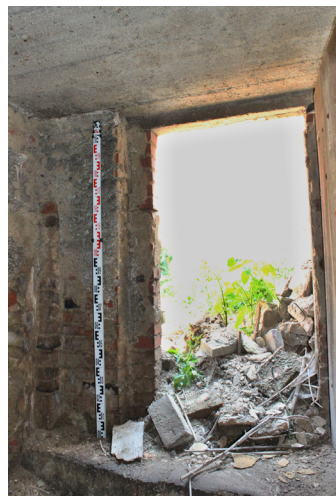
P.02_10. Východní stěna, dveře D 1 P.02_01, pohled od jihozápadu.
