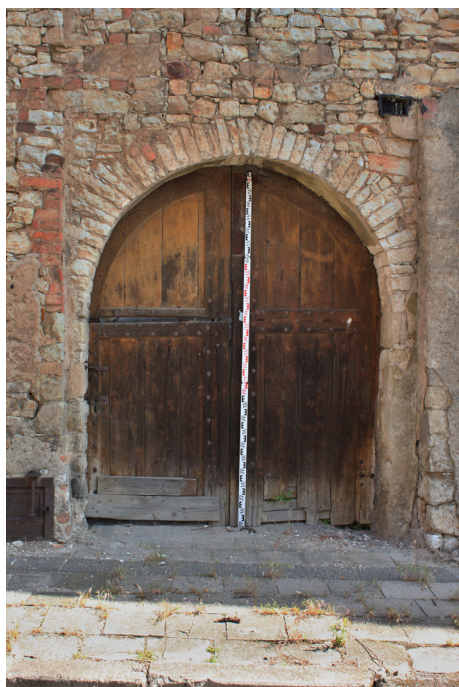
E.01_05. Jižní průčelí jižního traktu, průjezd s vraty V 1 P.01_01, pohled od jihu.
