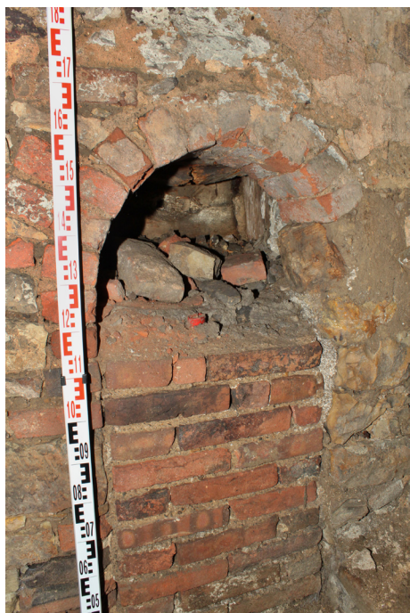
S.01_06. Východní stěna, částečně zazděná půlkruhově ukončená nika (S.01_B), pohled od severozápadu.
