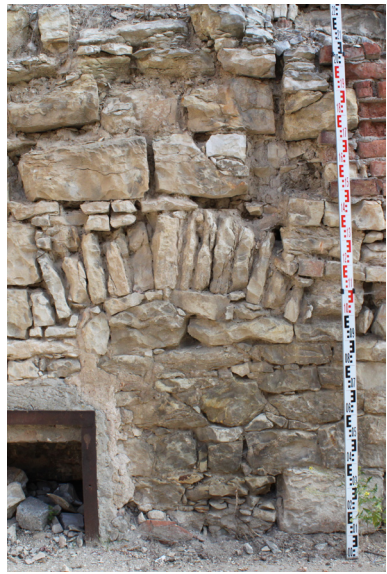
E.01_21. Jižní průčelí jižního traktu, zazděný vnější líc bývalého okenního otvoru ve druhé ose od západu (E.01_E), pohled od jihu.
