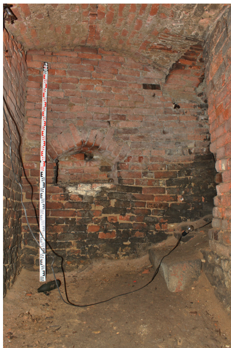
S.04_03. Severní stěna, pohled od jihu.
