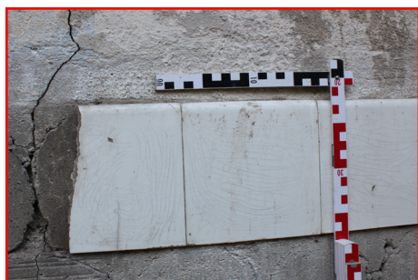
1.02_08. Západní stěna, severní část, detail obkladů (1.02_B), pohled od východu.
