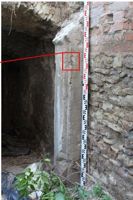
P.01_27. Portál P 2 102_01, severní stojka, pohled od východu.
