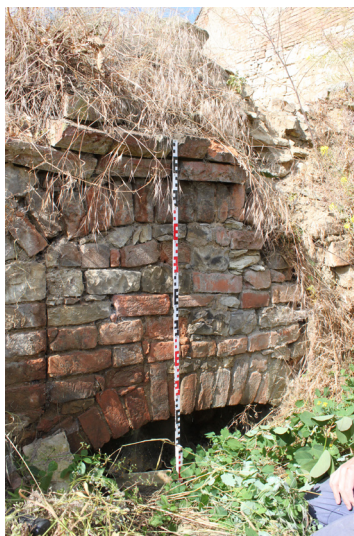
1.05_02. Jižní stěna, segmentové záklenky ( 1.05_A ), pohled na východní od severovýchodu.
