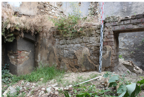
P.06_12. Východní stěna, severní část, pohled od jihozápadu.
