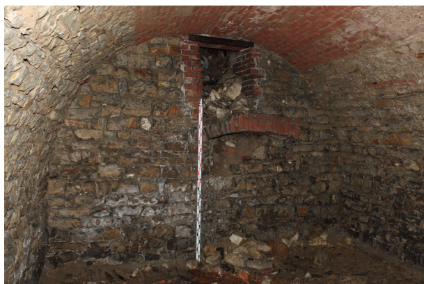
S.05_01. Jižní stěna, pohled od severu.
