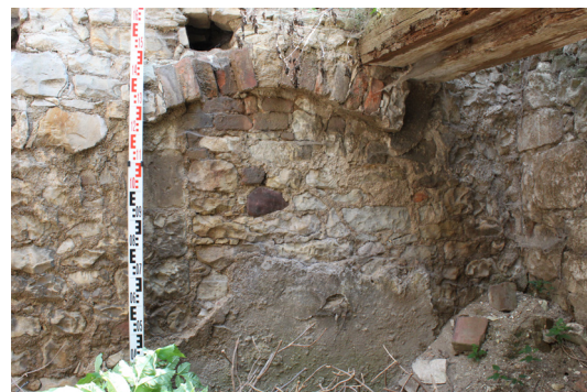
P.05_09. Východní stěna, jižní část s vylehčovacím obloukem (P.05_B) nad zazděným vstupem do místnosti P.06, pohled od západu.
