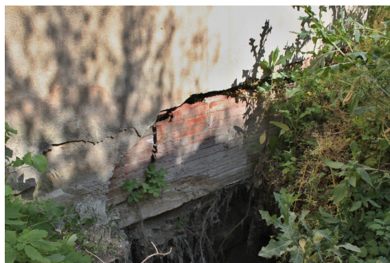
1.03_15. Západní stěna, severní část, detail cihel, ze kterých je stěna postavena, pohled od jihovýchodu.
